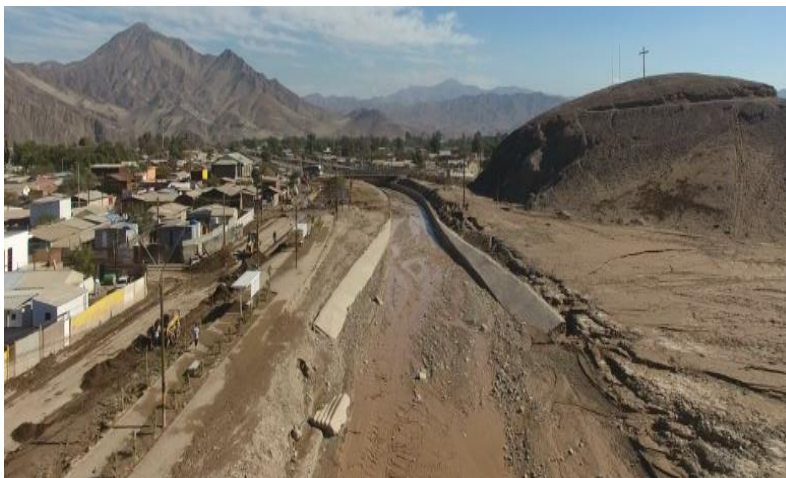
Ilustración 20. Inicio de la obra de encauzamiento canal de protección, se aprecia obra post evento 25M Fuente: SEIA, 2018
