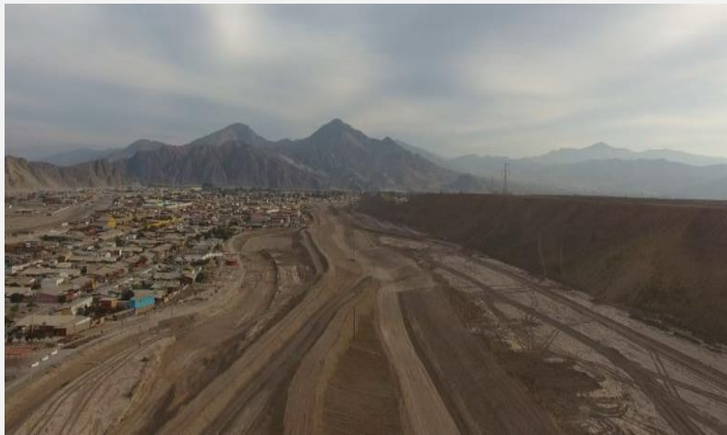
Ilustración 21. Canalón natural de quebrada Paipote y obras de “perfilamiento urbano” Fuente: SEIA, 2018
